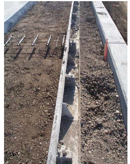
Steel forms in place for hand pour
